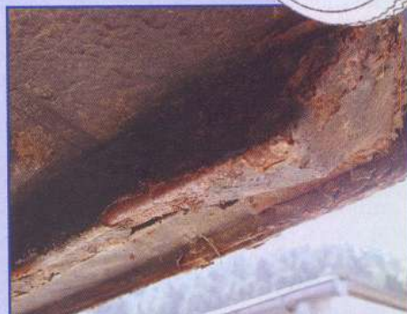
Schwellen-Angst berechtigt: Außen- und Innenschweller sowie die Endspitzen sind...
