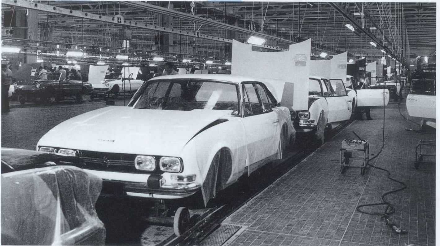
C'est sur les chaînes d'assemblage de Pininfarina à Turin que furent construites les 504 Coupé et Cabriolet. On reconnaît, au fond, sur une chaîne parallèle, la chaîne de montage des cabriolet Alfa Romeo Duetto.
