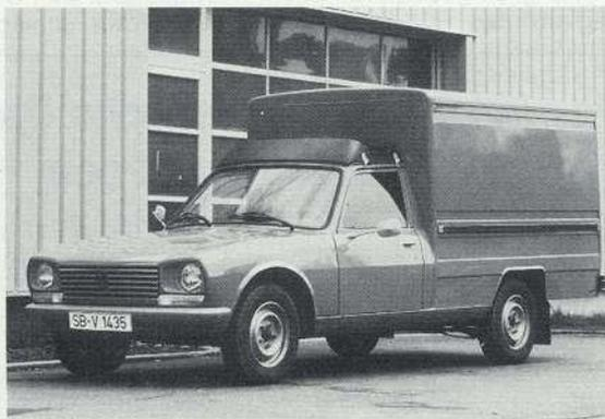
Geschlossener Kasten mit seitlicher Schutzleiste, der Dachgepäckträger aus Kunststoff ist gleichzeitig als Windabweiser gedacht.
